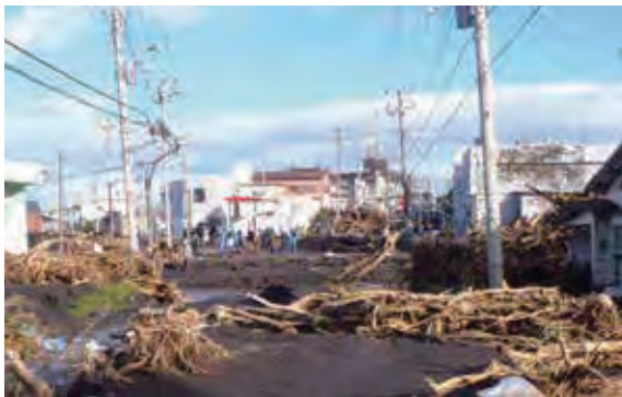
土石流により道路まで流れ込んだ土砂や流木(大島町) [平成25(2013)年10月の台風第26号] 提供: 気象庁
