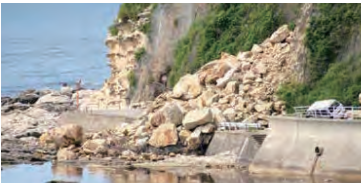
地震によるがけくずれ(石川県輪島市)[平成19(2007)年 能登半島沖地震]
