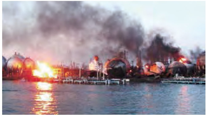
千葉県市原市のガスタンク火災[平成23(2011)年 東日本大震災]
