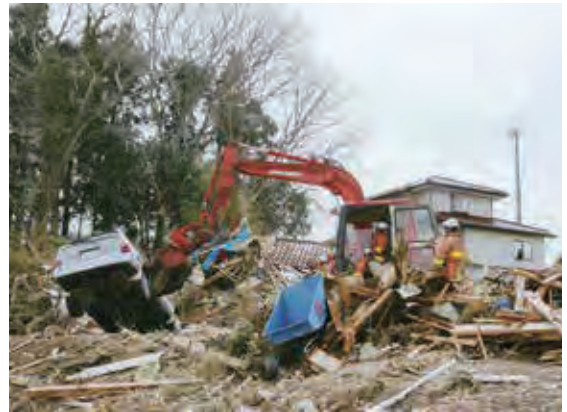
とくしゅじゅうき 特殊重機による、がれきの撤去作業
