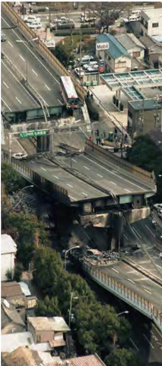
崩壊した阪神高速道路 提供：神戸新聞社
