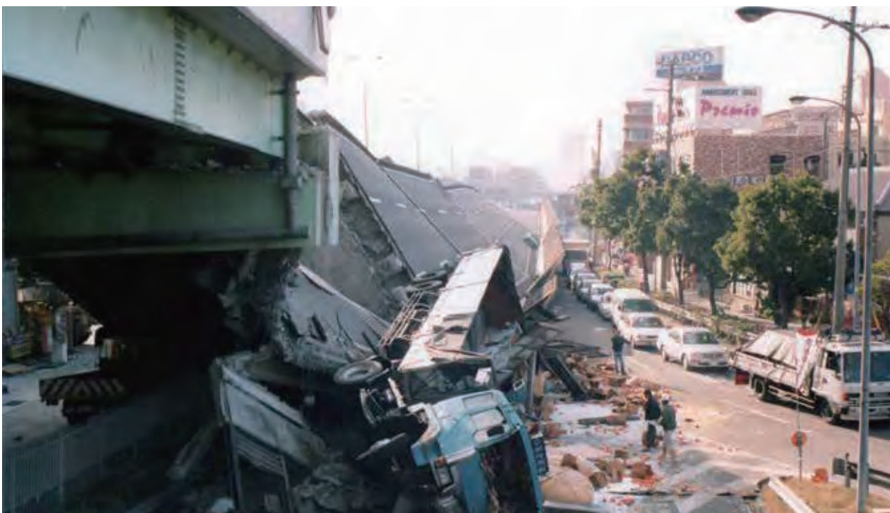
倒壊した高速道路 [平成7(1995)年 阪神・淡路大震災] (提供：神戸市)
