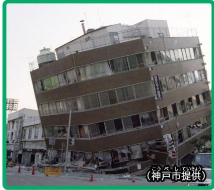
地震のゆれで たおれたビル。 (神戸市提供)
